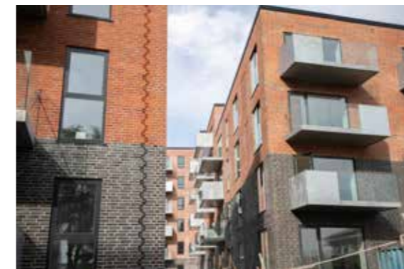
JCN Bolig har opført 87 eksklusive boliger i Rødovre, som etagebyggeri i op til 6 plan fordelt på 8.424 m 2 . Kontrakten blev indgået med Thomas Bloch fra AEP.
