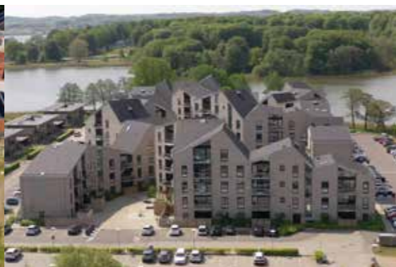
Ovenvande omfatter 128 boliger på i alt 13.540 m 2 og er opført med bærende konstruktioner i betonelementer og med listepantag. Projektet er opdelt i 2 etaper og opført for 2 forskellige bygherrer.
