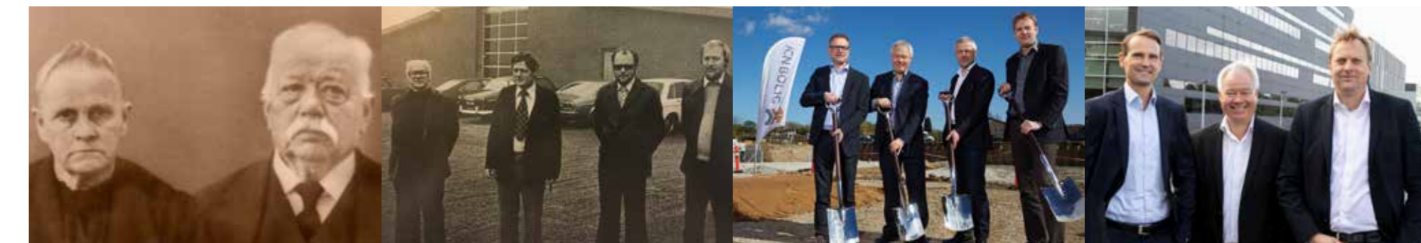
JCN startede helt tilbage i 1898, da Kirstine og Christian Nielsen flyttede til Timring. Chr. Nielsen var den tids "total-entreprenør", da han var uddannet tømrer, men egentlig hellere ville mure.
