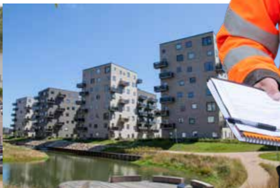
Lokesvej er 164 familieboliger, som er udviklet af Innovater i samarbejde med NREP og opført i totalentreprise af JCN Bolig sammen med Årstiderne Arkitekter og Midtconsult. Projektet var en del af det samlede Åbyen-projekt, hvor JCN Bolig opførte ialt 830 boliger.
